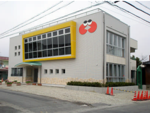
新築された南保育所仮園舎
