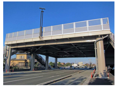
歩道橋を利用した避難タワー
